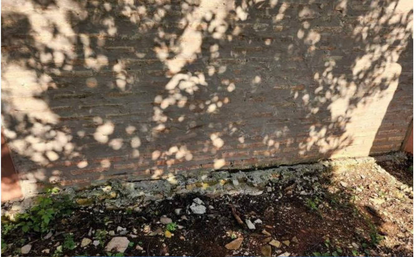
Construcciones en la Escuela Básica n° 475 Defensores del Chaco, Contrato N° 14/2020, ID N° 386950
